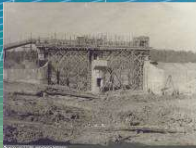
Сооружение плотины на реке Протве
